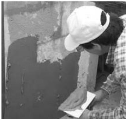
**Aplicación:** Se extiende con llana metálica, fratás de madera ó plástico directamente sobre el bloque una primer capa de 1 mm de espesor.
