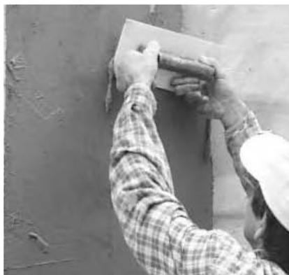
Luego se aplica la segunda capa de terminación. Una vez que se ha producido el tirado del material (el tiempo dependerá de las condiciones climáticas en obra) se procede al acabado con fratás de fieltro o esponja ligeramente humedecido.
