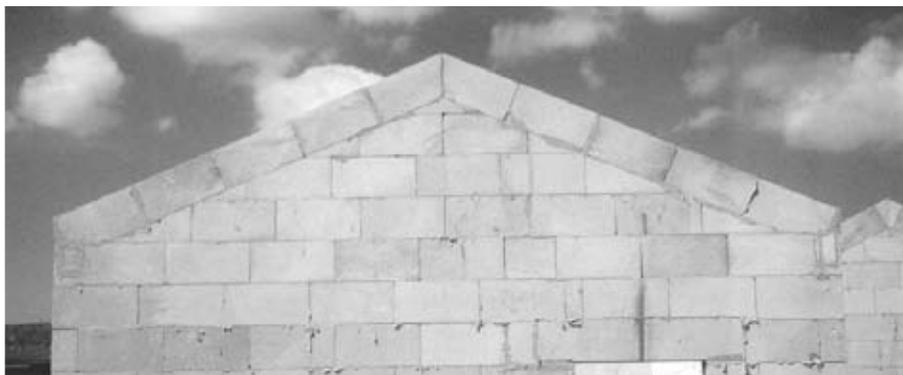
■ En techos inclinados, a un agua o a dos aguas, en que el muro cierra en un triángulo, la viga de encadenado puede ejecutarse inclinada desde el nivel de arranque de techos hasta el nivel de cumbrera, como se observa en las fotos. Si la pendiente es poca, caso de un techo de chapa y paredes no muy largas, se puede realizar el encadenado horizontal a un mismo nivel y luego realizar refuerzo de hierro en el mojinete que completa la pared hasta el techo.
